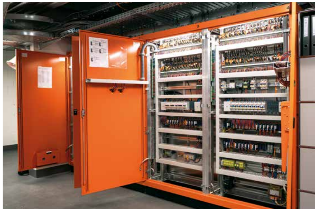
Schaltgerätekombinationen für die Gebäudeautomation.
