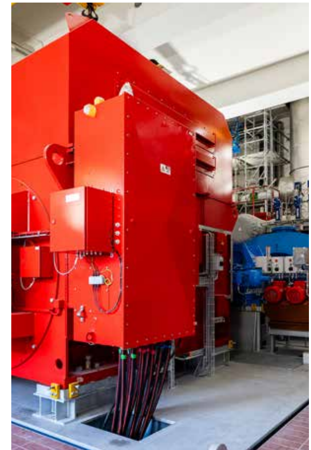
Neue Transformatoren, diverse Elektromotoren und eine neue Turbo- gruppe: Die Gelben verkabeln in der KVA Linth die neuen Kern- stücke der Anlage.
