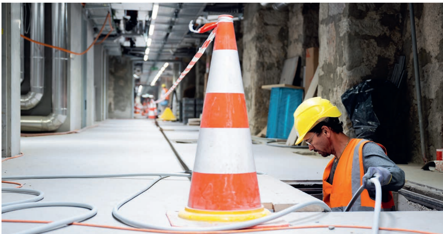
Im Untergeschoss sind mehrere Elektriker dabei, Kabel in die grosse Rohranlage einzuziehen.
