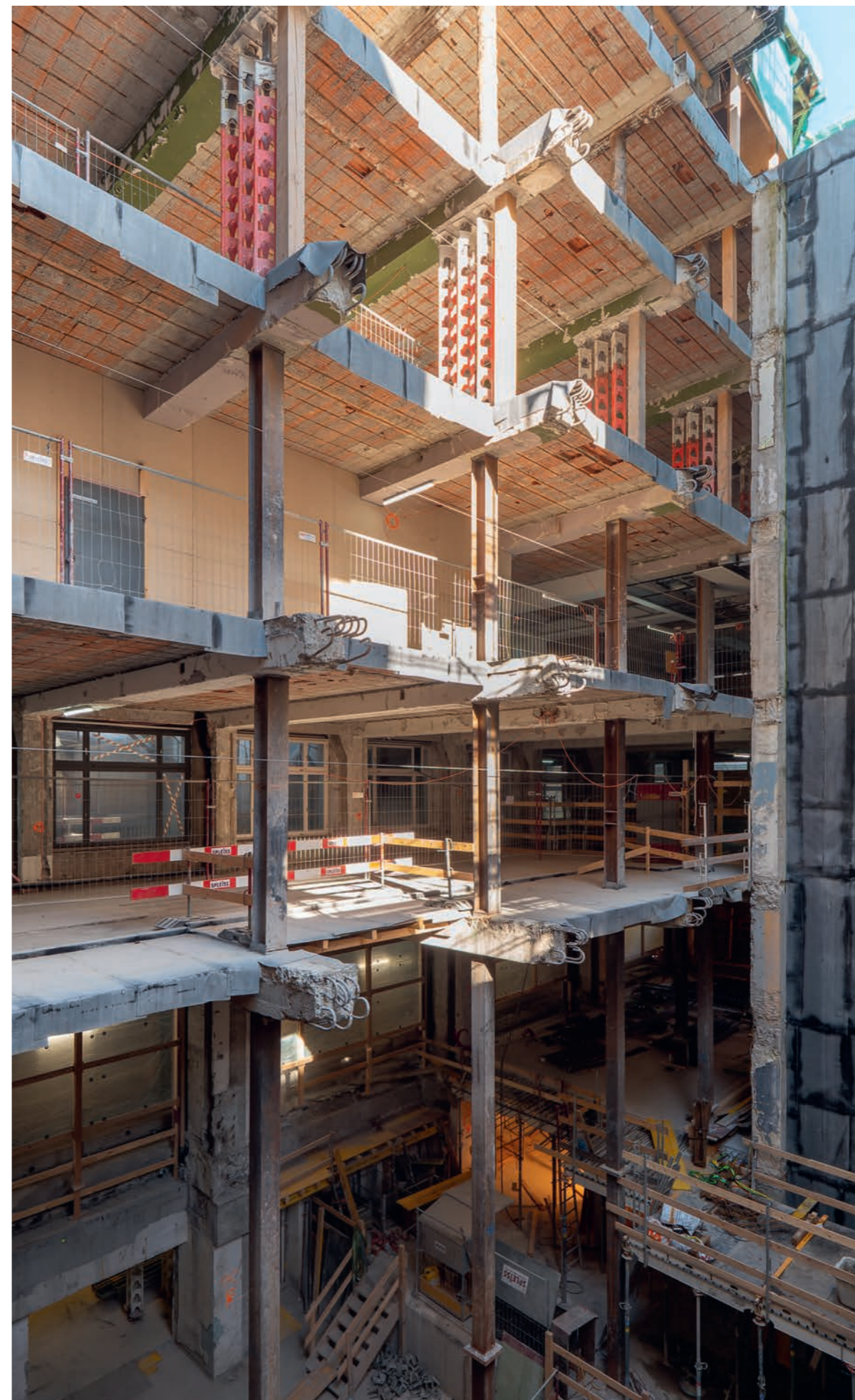
Auf der Baustelle sind die Gelben vom Rohbau bis zu den Abschlussarbeiten gefordert.
