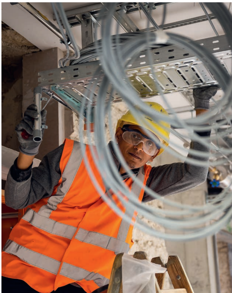
Im Untergeschoss sind mehrere Elektriker dabei, Kabel in die grosse Rohranlage einzuziehen.
