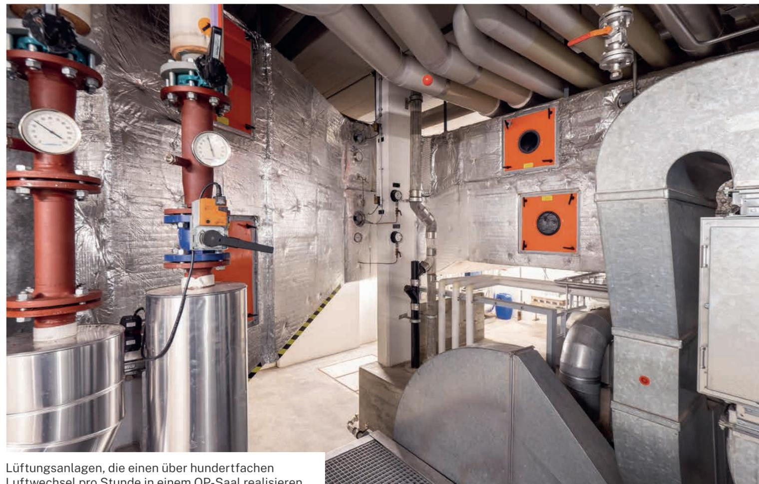
Lüftungsanlagen, die einen über hundertfachen Luftwechsel pro Stunde in einem OP-Saal realisieren.
