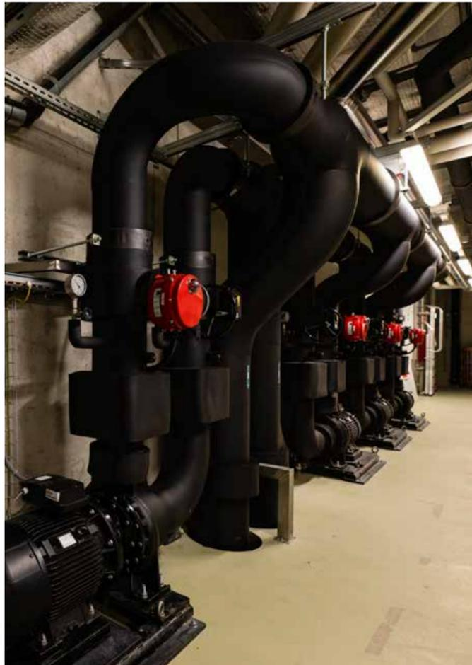
Vier Kälteloop-Pumpen mit den dazugehörigen Frequenzumformern optimieren auf dem Areal den Kältekreislauf.
