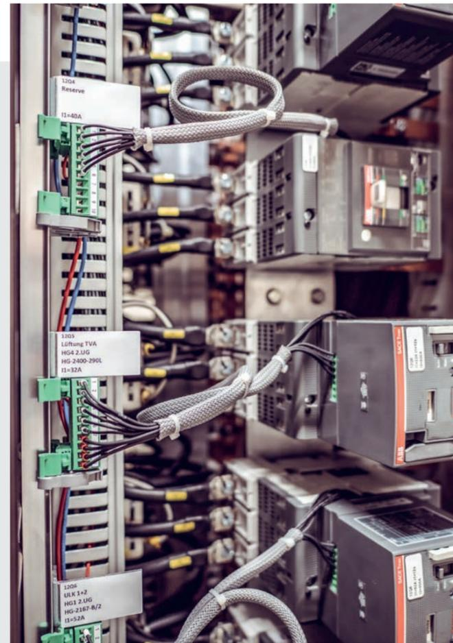
132 Abgangsschalter der neuesten Generation wurden in die beiden Hauptverteilungen eingebaut.
