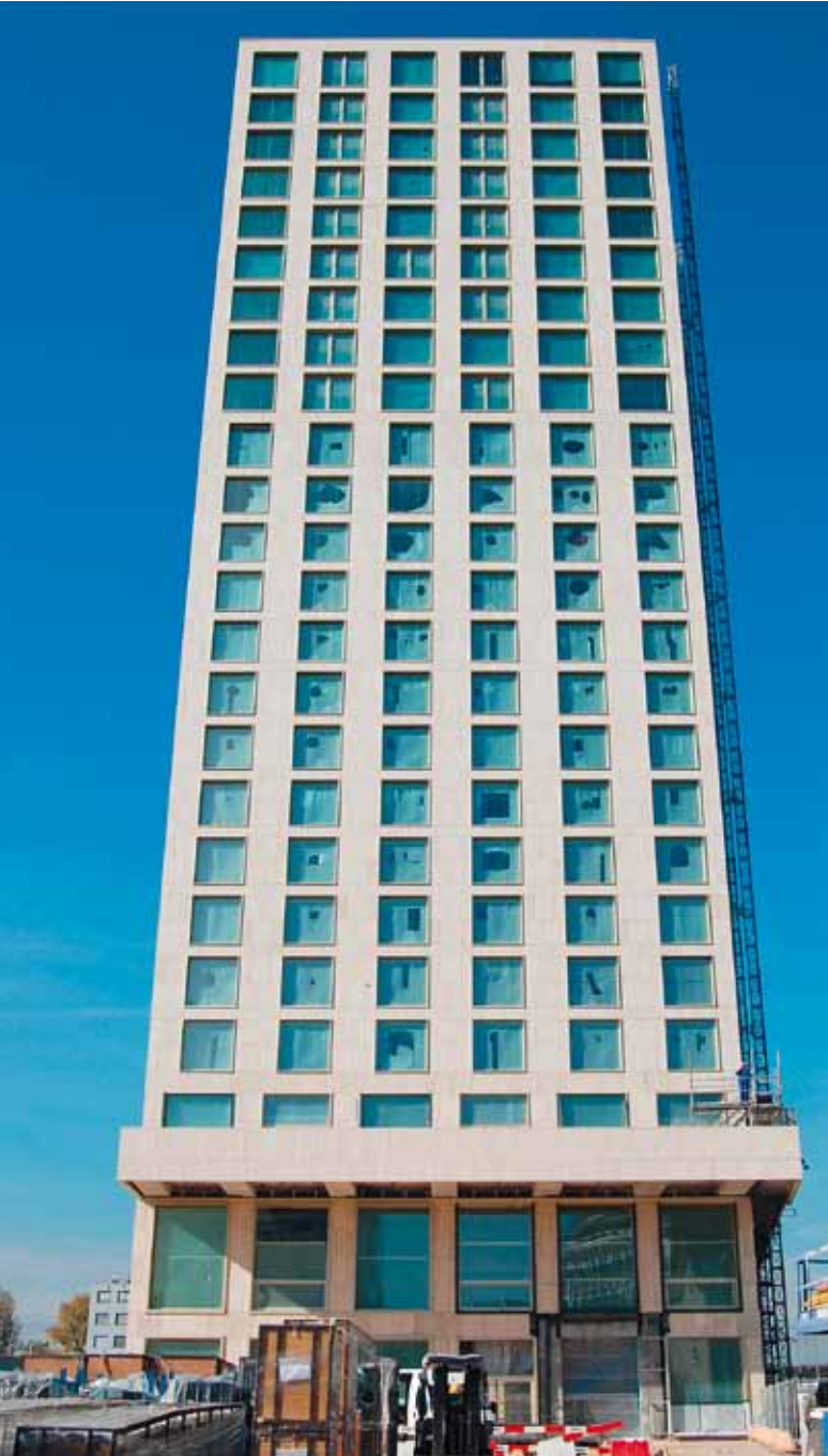
Oben: Der Mobimo Tower mit seiner Travertinfassade. Die unteren 15 der 24 Geschosse sind dem Hotel vorbehalten.
